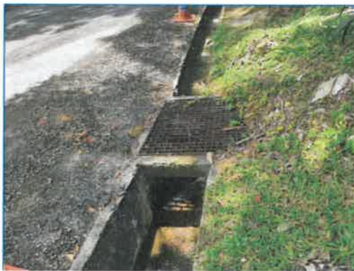
ภาพถ่ายที่ 2.2-4 ตะแกรงดักมูลฝอยบริเวณจุดระบายน้ำ
